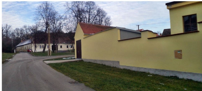
Stavební úpravy skladu - PO REKONSTRUKCI
